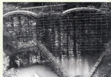
建設中の轟橋、アーチを 組む様子がよくわかる。
