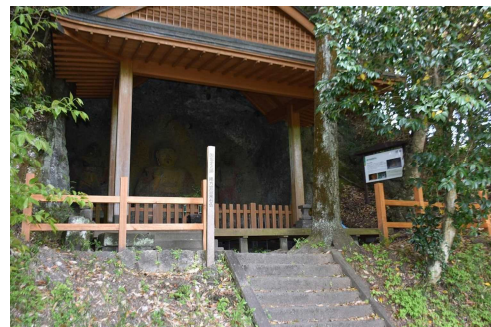
手すりの改修（宮迫東石仏）
