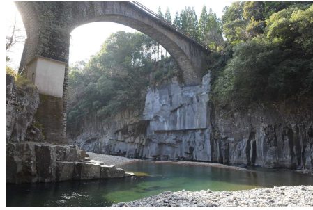
修復工事後の轟橋下岩壁
